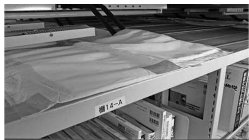
図2 吸水マットを養生テープで止める
